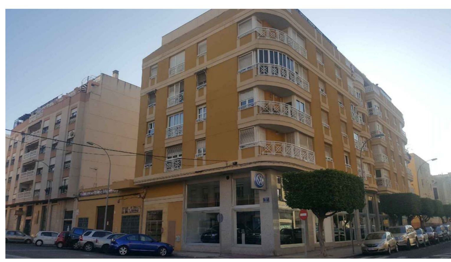
FOTOGRAFÍA DE ESTADO ACTUAL DE LA EDIFICACIÓN EXISTENTE DONDE SE UBICA EL LOCAL OBJETO DEL PROYECTO
